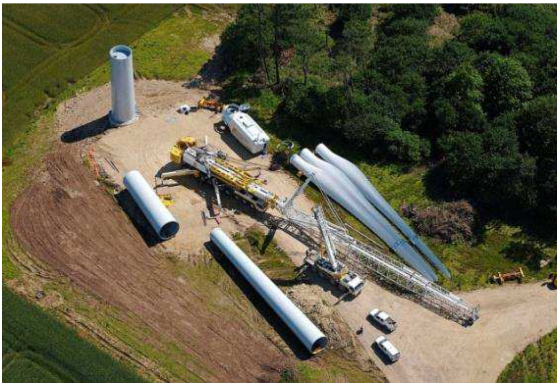
Illustration d'un chantier de construction d'un parc éolien. Source : ENGIE GREEN.
